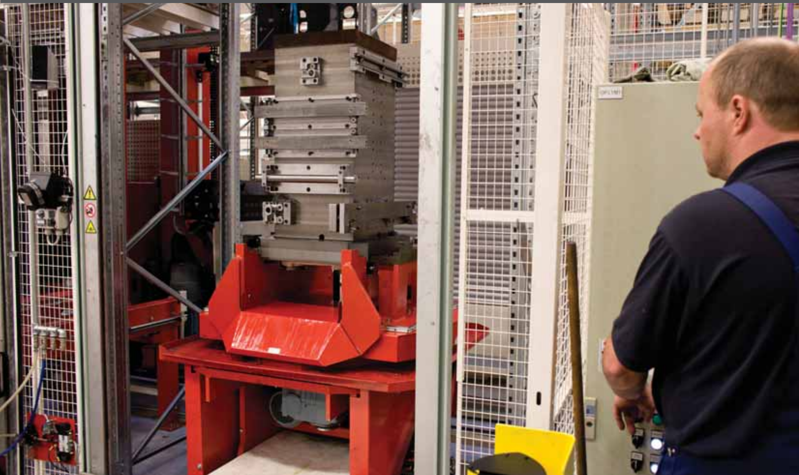
Det fuldautomatiske Fastems-anlæg er 7,5 meter i højden og 36 meter i længden.
